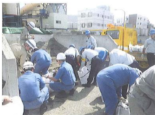
土嚢作成状況
