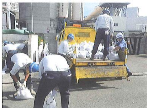
土嚢積みこみ状況
