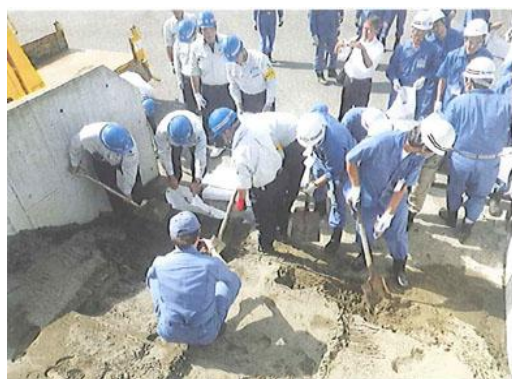
土嚢作成状況
