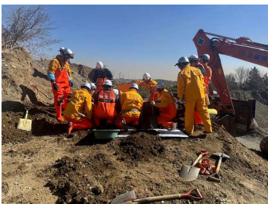
青葉消防署 隊員による人力掘削
