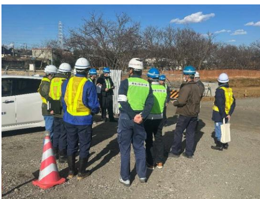
県道川崎町田(恩田地区)道路改良工事(その8)
