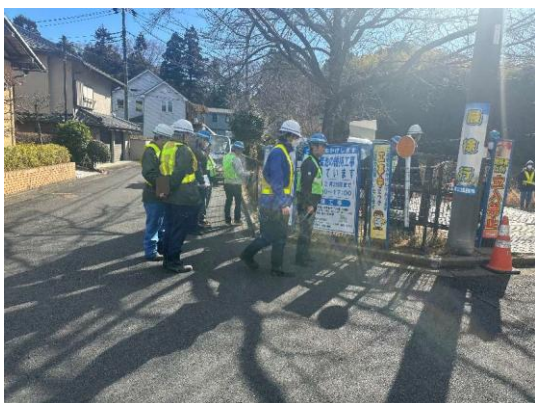
青葉区奈良2号雨水調整池ほか浚渫工事
