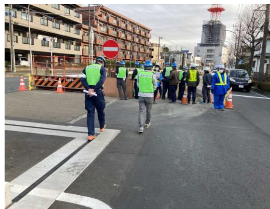
主要地方道横浜生田平原橋交差点改良工事(その2)
