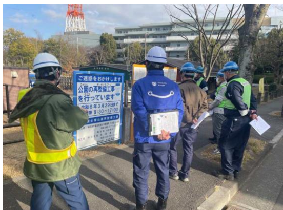
荏田富士塚公園再整備工事
