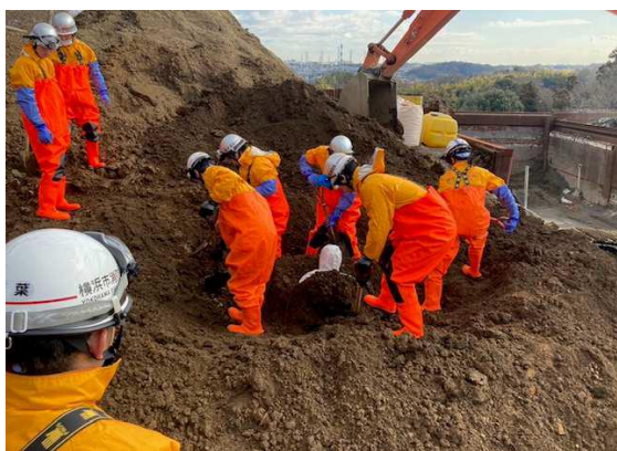
青葉消防署 隊員による人力掘削
