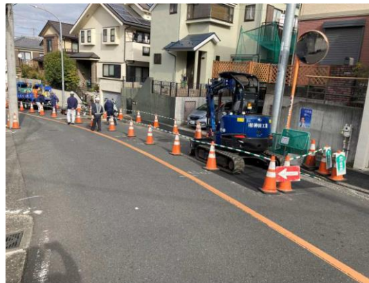
都筑処理区青葉区若草台地区下水道再整備工事
