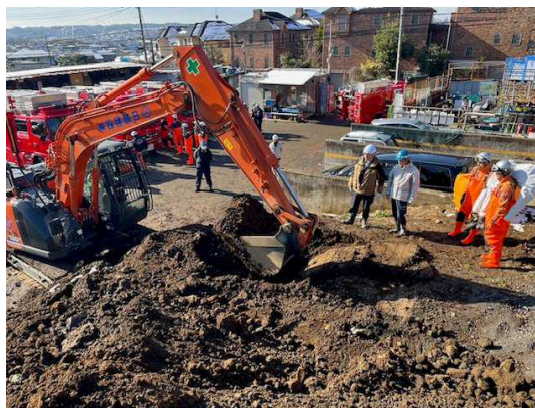
青葉区会員による重機掘削
