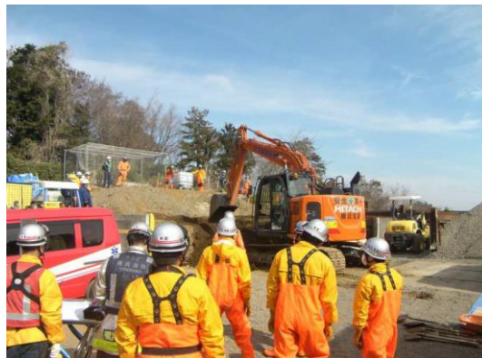
区会員による重機掘削
