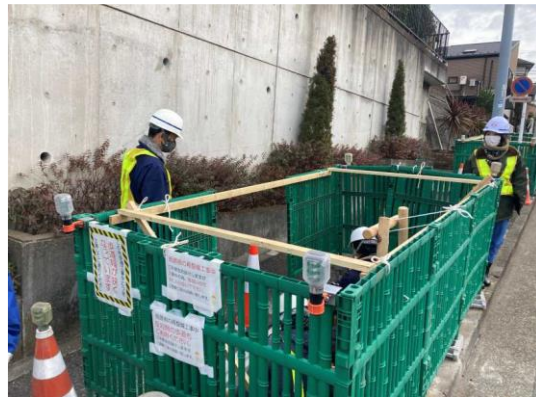
青葉区市道黒須田第313号線ほか1路線街路樹再整備工事
