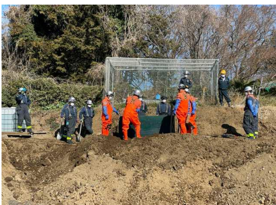
青葉消防署 隊員による土留め設置
