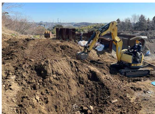
青葉区会員による重機掘削
