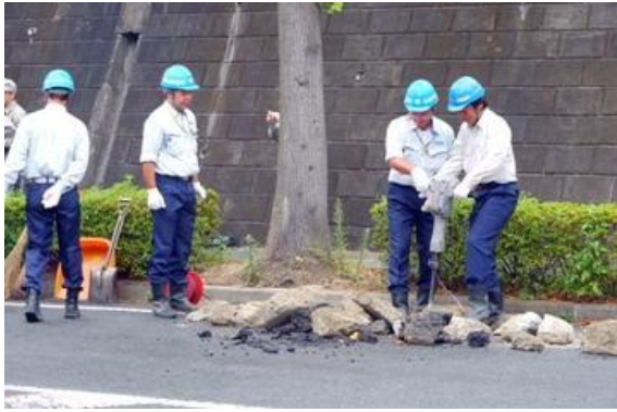
倒壊したブロックをドリルで切断して除去
