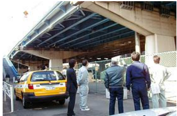
橋梁を点検する鶴見区会員と土木事務所
