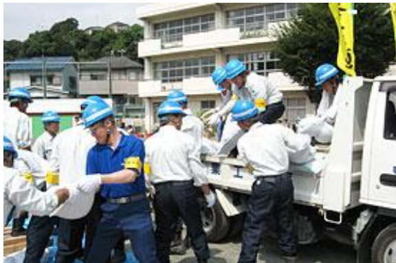
陥没した道路の復旧作業を行う中方面班
