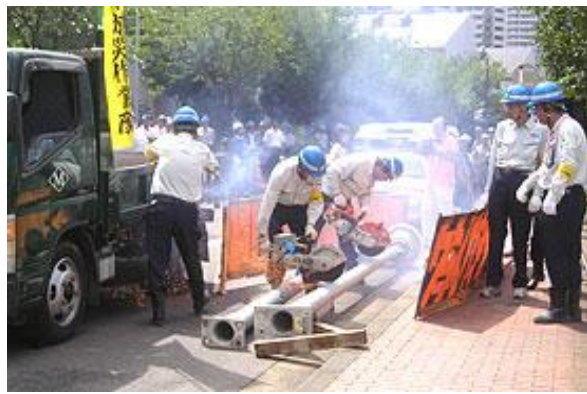
倒壊した街路灯の切断を行う戸塚方面班
