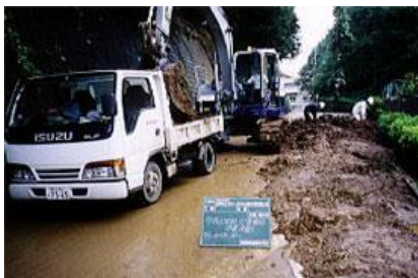
道路をふさいでいる樹木等の撤去
