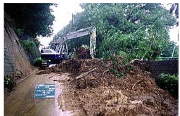
土砂撤去状況－1
