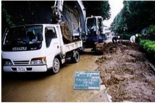
土砂撤去状況-2
