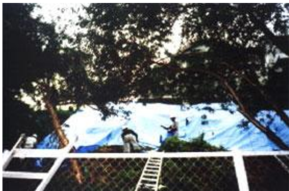
がけ崩れの二次災害防止のためシート張り作業 (神奈川県松見町)
