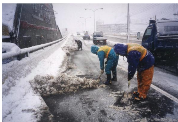
県道 横浜生田線 陸橋部の除雪作業。
