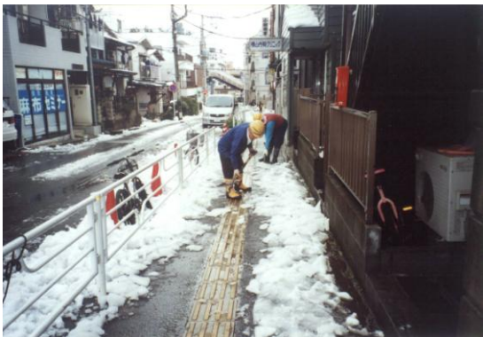
盲学校への通学路を確保するための除雪作業
