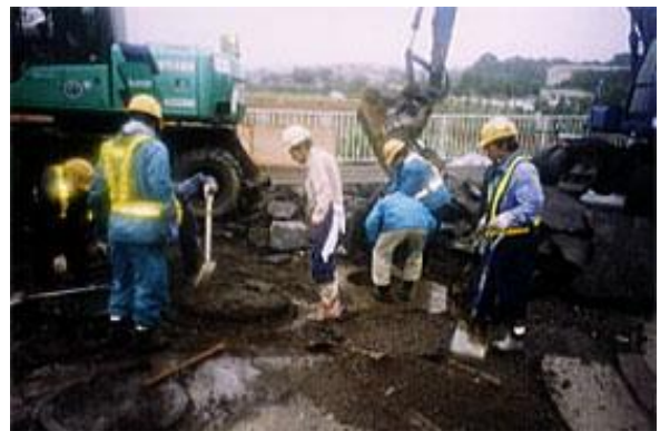
舗装復旧作業(戸塚区戸塚町附近)
