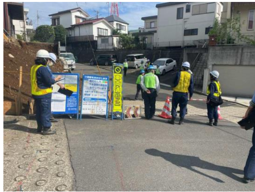
都筑処理区梅が丘地区下水道整備工事
