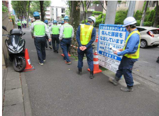
青葉区新石川二丁目地内ほか1か所舗装補修工事
