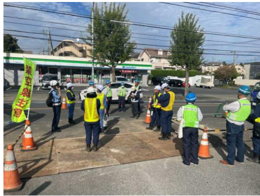
青葉区青葉台二丁目地内ほか5か所道路整備工事
