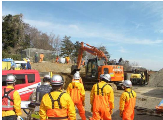
区会員による重機掘削
