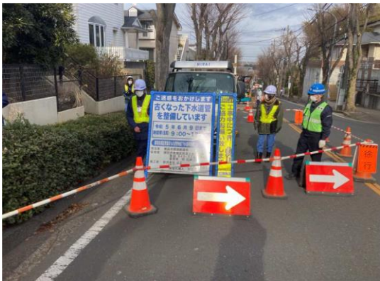
都筑処理区青葉区もえぎ野地区下水道再整備工事(その5)
