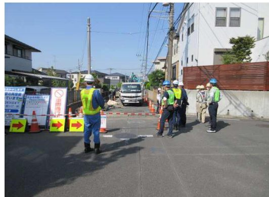
都筑処理区青葉区鴨志田町地区下水道再整備工事
