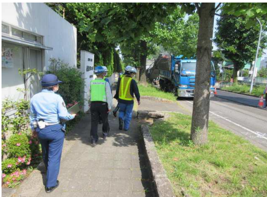
青葉区美しが丘三丁目地内舗装補修工事(ゼロ市工事)
