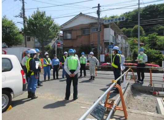
主要地方道横浜生田平原橋交差点改良工事(その1)
