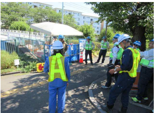
青葉土木管内道路整備工事(その1)(ゼロ市工事)
