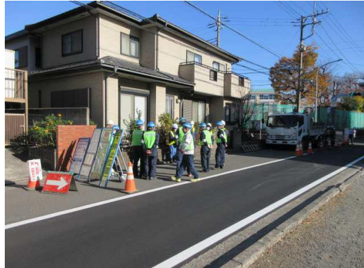
都筑処理区等地域防災拠点(あかね台中ほか) 流末枝線管きょ耐震化工事
