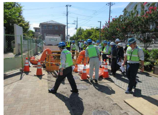
災害時下水直結式仮設トイレ用下水道管整備工事(その437)
