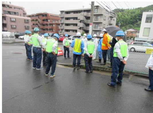
都筑処理区等地域拠点(あかね中ほか)流末枝線管きょ耐震化工事
