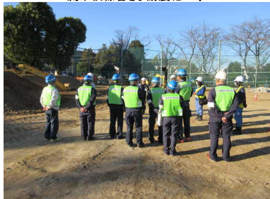
鴨志田公園ほか5公園施設改良工事
