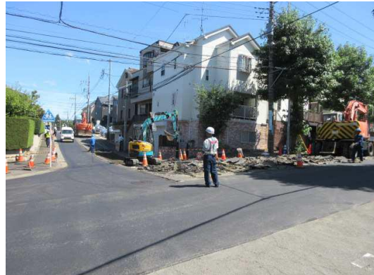
青葉区柿の木台地内舗装補修工事
