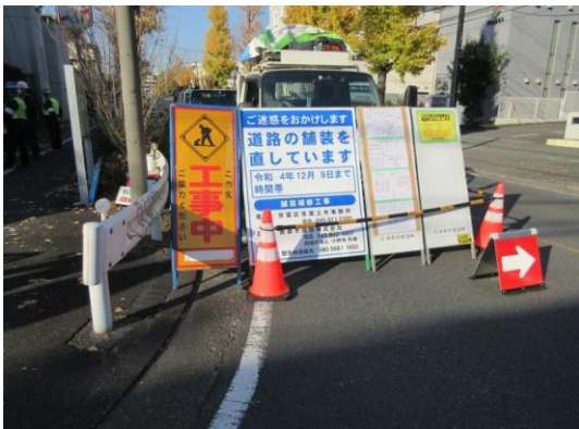
青葉土木管内舗装補修(応急修理)工事(その4)
