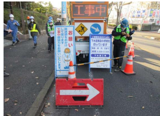
青葉土木管内下水道修繕工事(その3)
