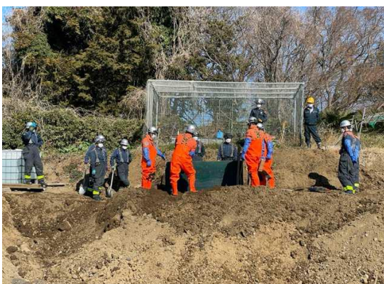
青葉消防署 隊員による土留め設置
