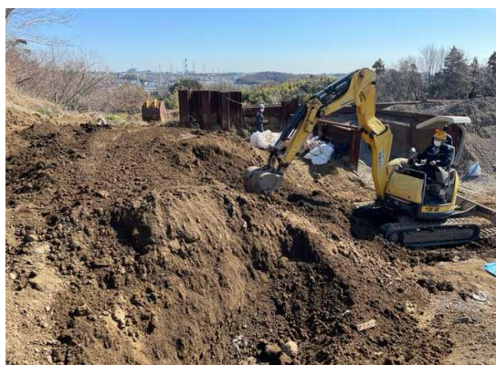
青葉区会員による重機掘削
