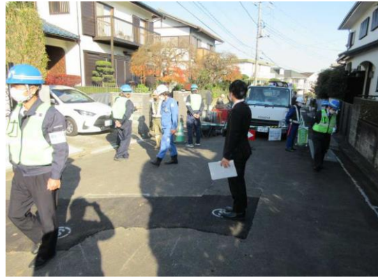
都筑処理区青葉区若草台地区下水道再整備工事
