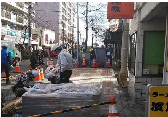
青葉区市ヶ尾町地内道路整備工事
