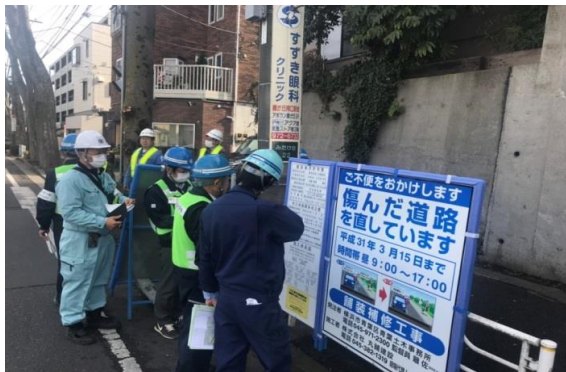
青葉区鴨志田町地内ほか1か所舗装補修工事
