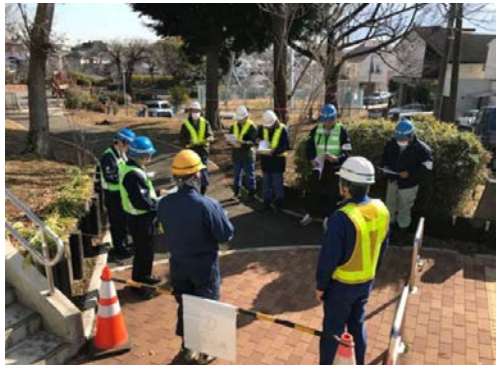
美しが丘二丁目地内道路整備工事（その2）（有）武城建設
