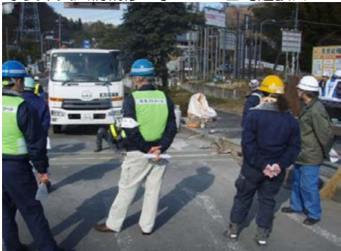
奈良中央大橋補修工事 山崎建設(株)
