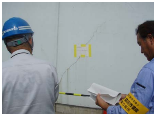
外壁調査状況
