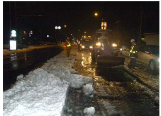
ショベルカーによる除雪作業
