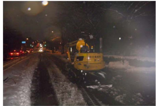
バックホー(0.15m 3 )による除雪
