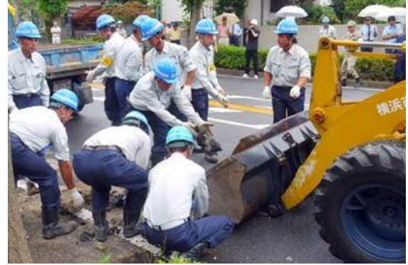
倒壊したブロックをドリルで切断して除去
